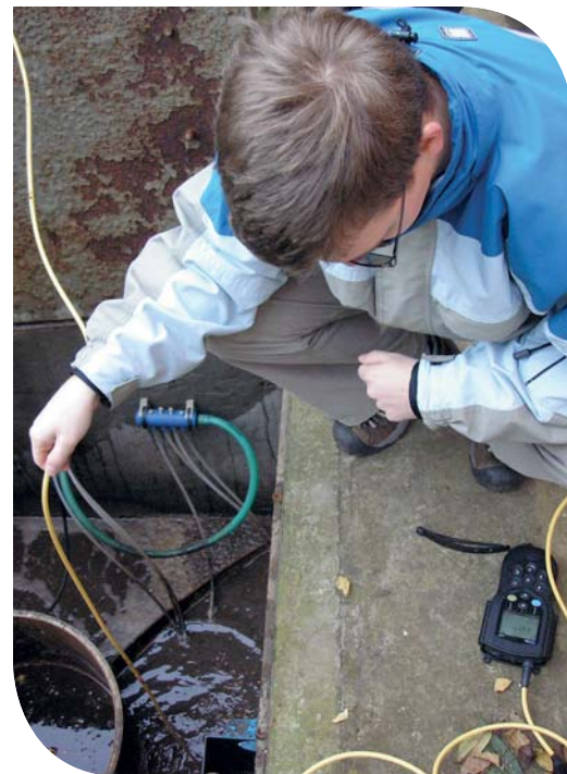
Domovní čistírna odpadních vod (ČOV)
